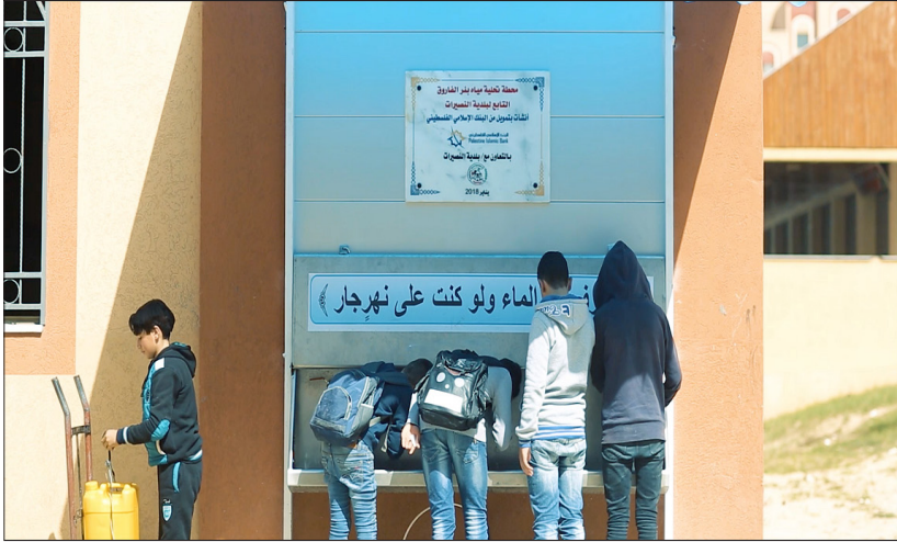
محطة تحلية مياه حي الفاروق التي أنشأها البنك في النصيرات
